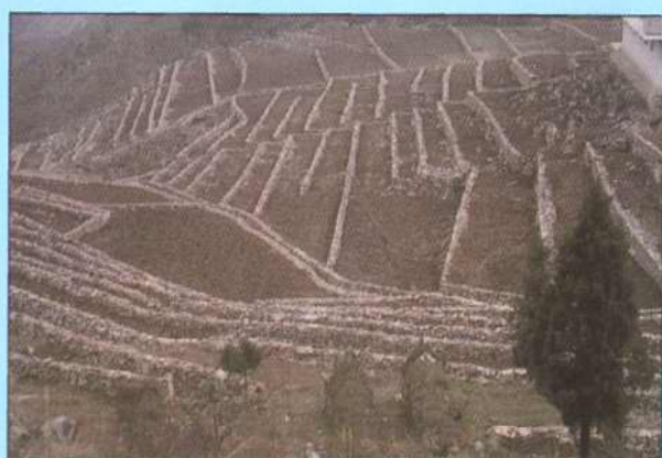
▲ 以工代赈项目实现的坡地改梯田工程
