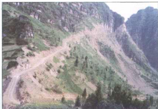
▲ 桫桤村民自力更生修建的的公路
