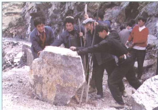
▲ 农民修建村级公路
