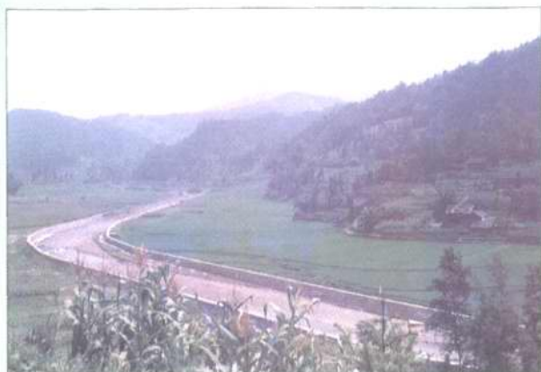
▲ 用财政扶贫资金修建的区阳河堤
