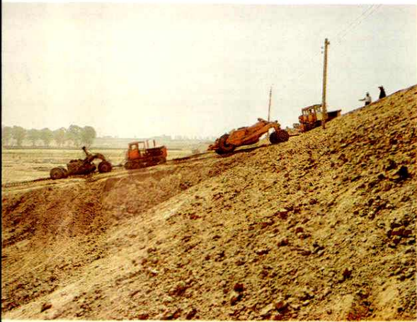
治黄专业队伍在利用铲运机等 施工机械修堤（王新民摄）
