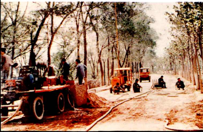
机械锥探灌浆加固黄河大堤
