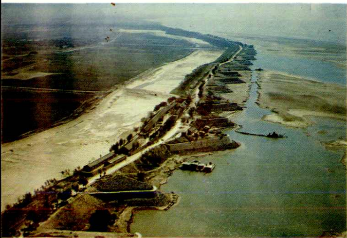
吸泥船放淤固堤
