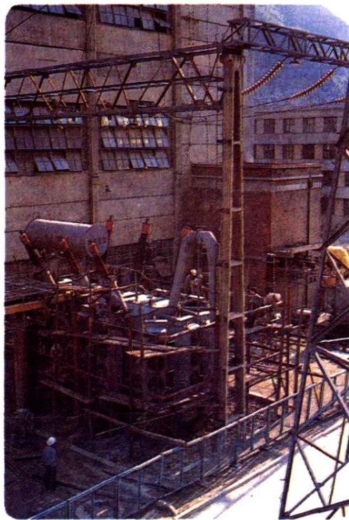
抢修"2主变压器
