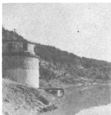
加挡湾电灌站（真空进水）
