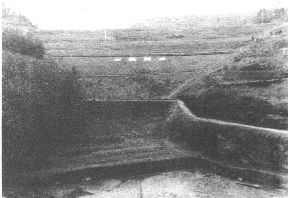
两河龙滩子水库大坝全景
