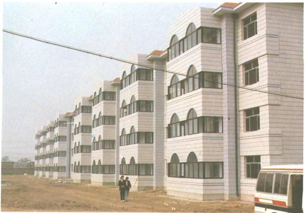
大站村 村民住宅楼
