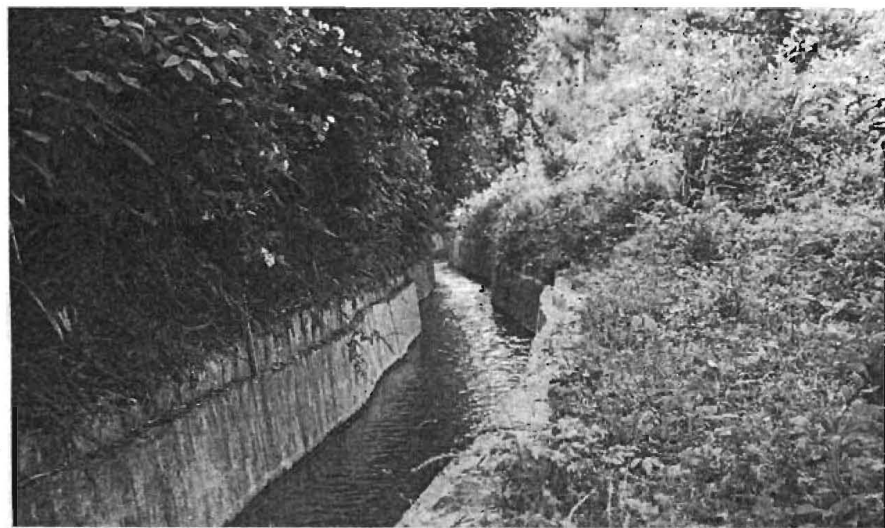
石井龙巴掌引水渠
