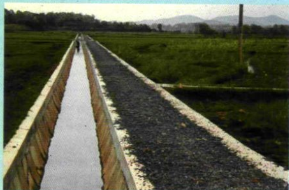
羊角塘镇泥湾村排洪渠
