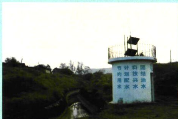
双牌渠道十三支渠太阳能节制闸
