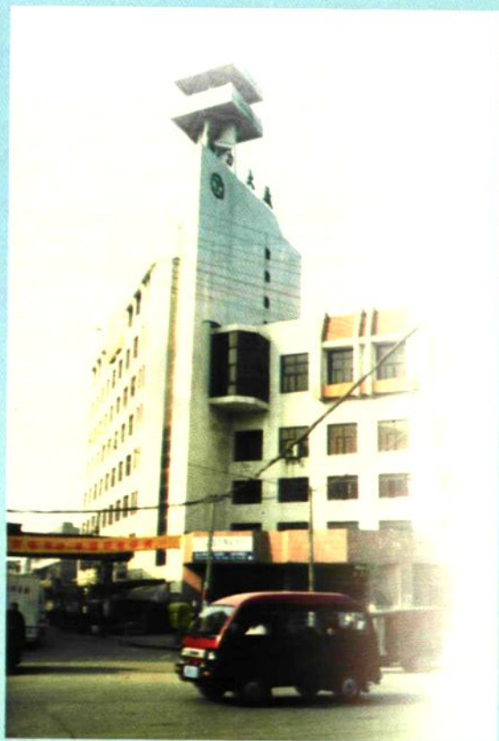
祁阳电力大厦
