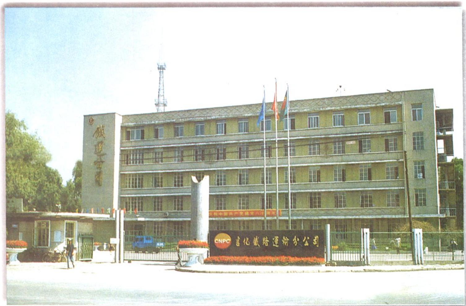
吉化铁运分公司办公楼
