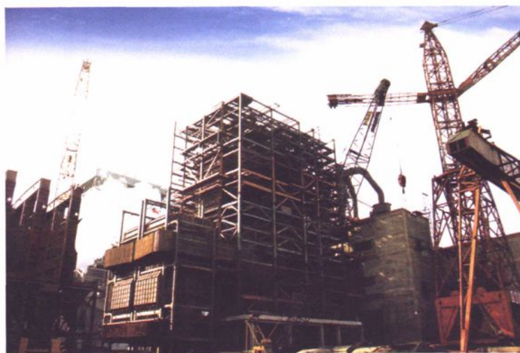
邯郸热电厂技改工程于1997年8月27日开工，图为施工现场
