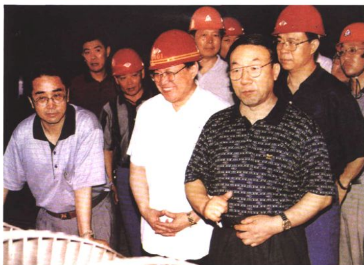
1998年6月16日，河北省省长叶连松到邯郸热电厂技改工程施工现场指导工作
