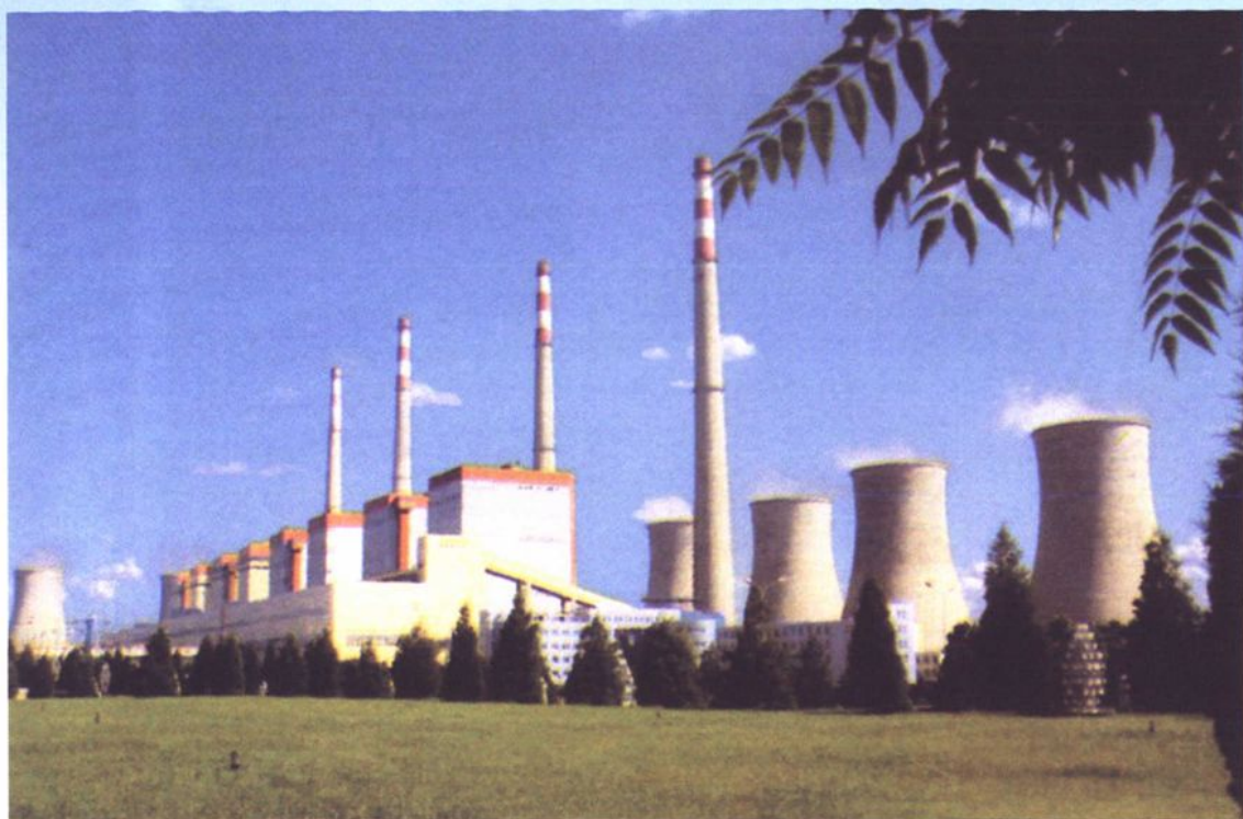
装机总容量达240万千瓦的张家口发电厂（2002年）
