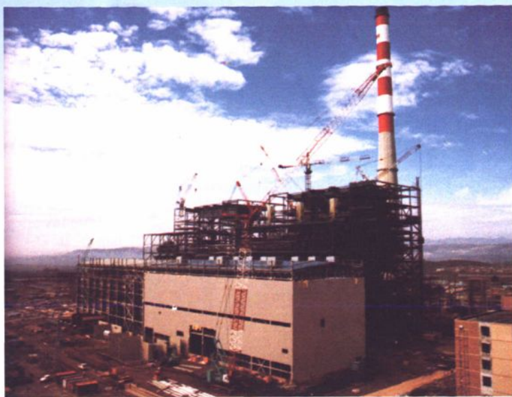
1996年12月8日，邯峰发电厂一期工程开工
