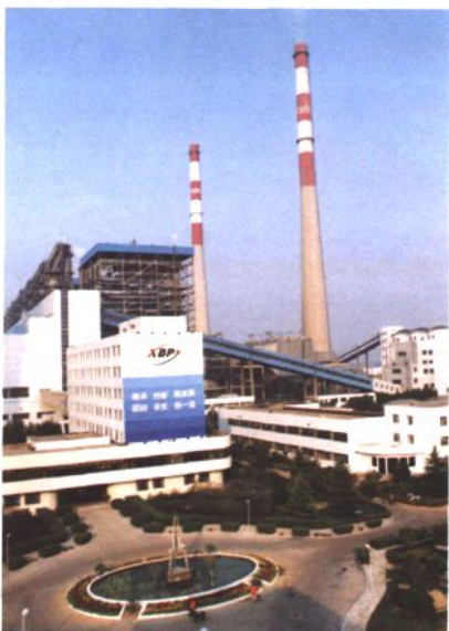
装机总容量达120万千瓦 的西柏坡发电厂(2002年)
