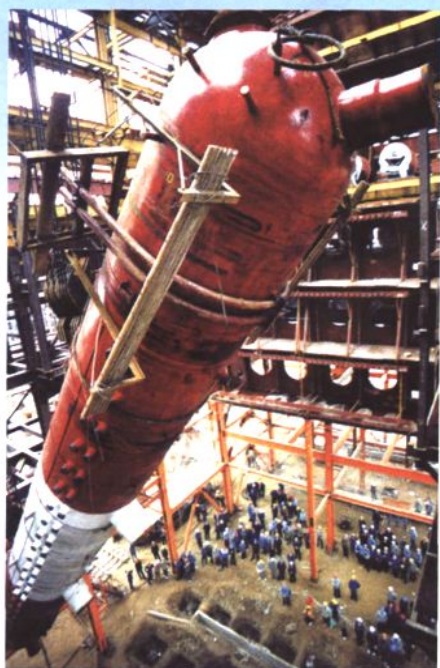
由河北电建一公司承建的西柏坡发电厂一号机组被电力部部长史大桢誉为“状元工程”。图为1025吨/时锅炉汽包吊装现场
