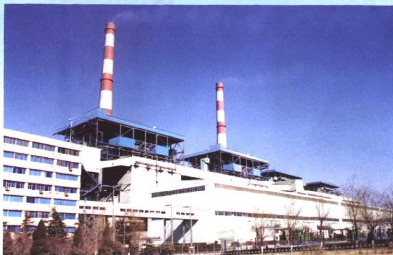
装机总容量达130万千瓦 的华能上安电厂(2002年)
