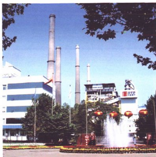
装机总容量达155万千瓦 的陡河发电厂（2002年）
