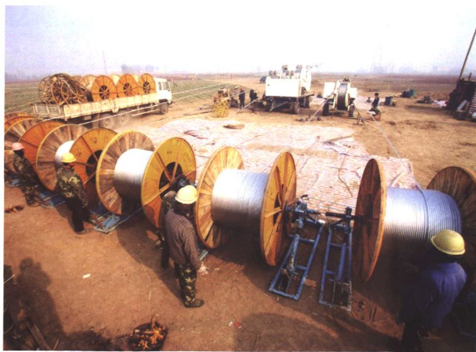
河北省送变电公司一牵六张力放线工艺施工现场
