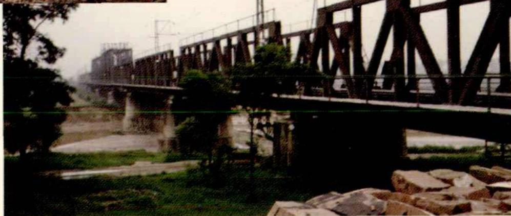
太原市第一座钢桁梁大桥
