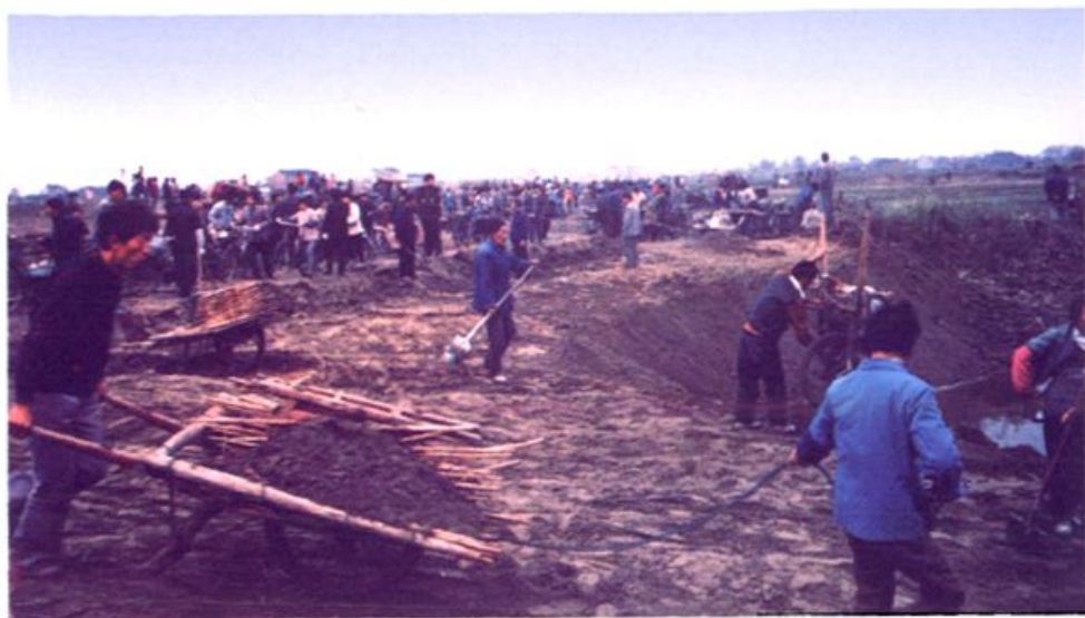
土地复垦整治现场
