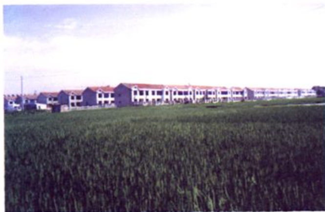
泰兴经济开发区 建成的农民住宅小区
