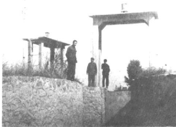
岔河咀站分水口
