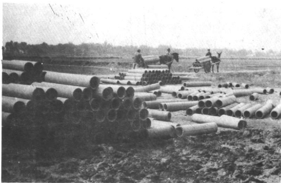
大街乡建设地下输水管道
