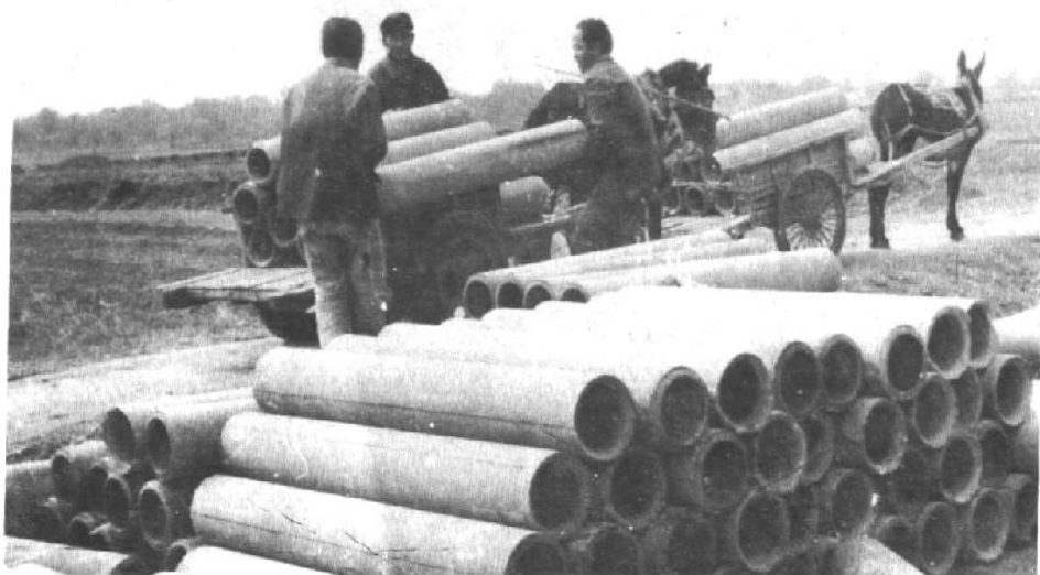
菅庄村地下防渗管道施工
