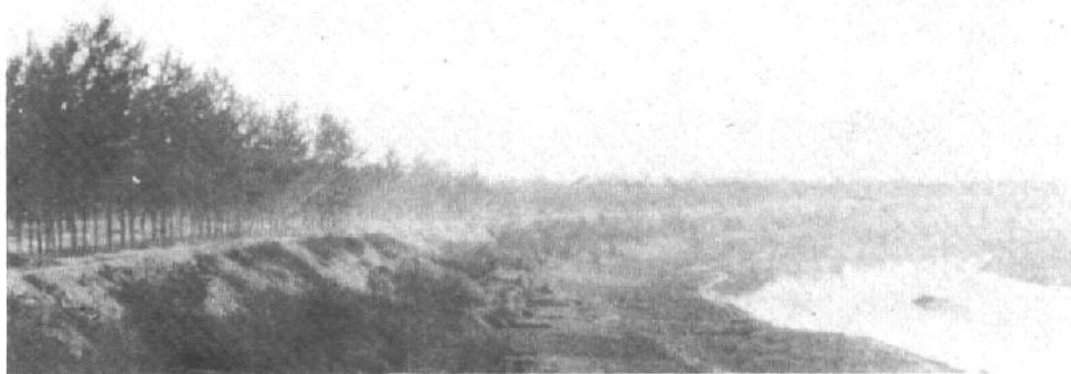
卫河龙王庙堤防段一角
