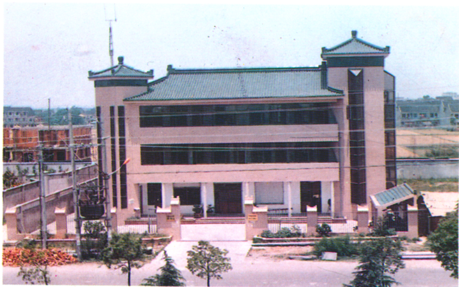
陆区乡电力管理站
