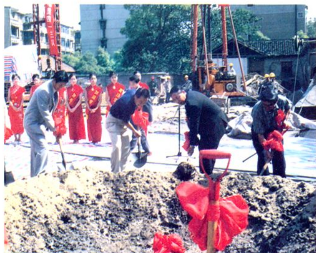
新住院大楼奠基动工兴建
