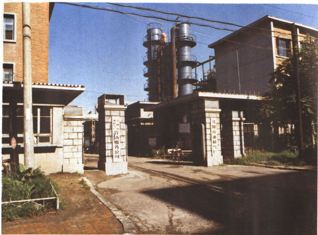
▲ 油制气厂门景
