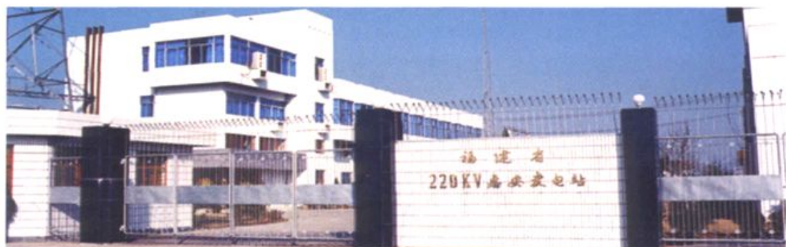
1992年3月竣工的惠安220千伏变电站
