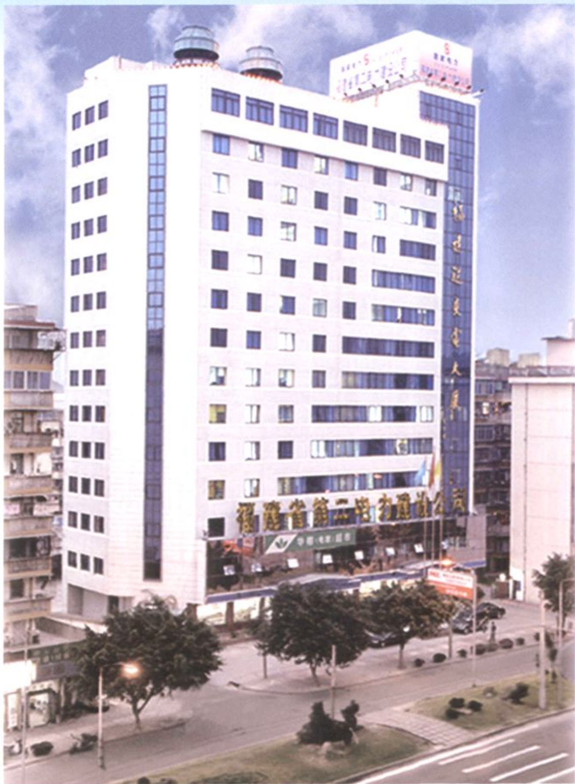
福建省第二电力建设公司办公大楼(2002年)
