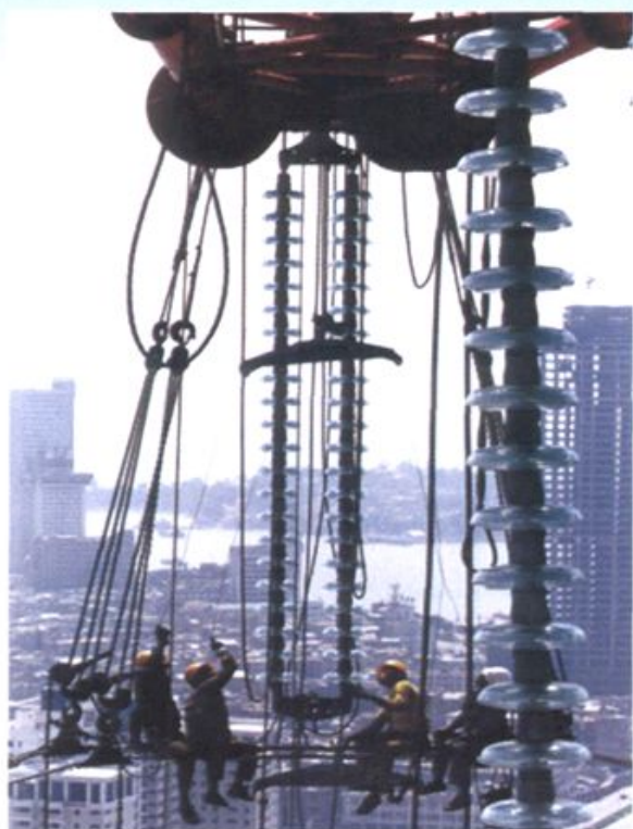
2001年9月，施工中的嵩厦 220千伏跨海高塔工程
