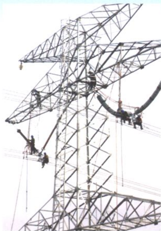
2000年，福建超高压运行 检修公司工人在运行的500千伏 线路铁塔上更换绝缘子
