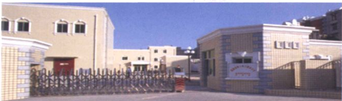
2002年10月竣工的厦禾220千伏变电站
