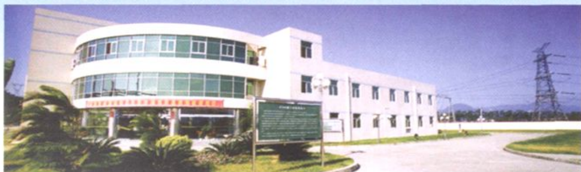
1999年2月竣工的厦门500千伏变电站
