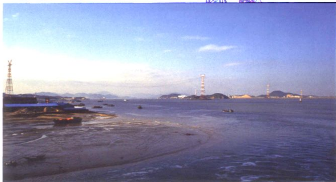
2001年10月竣工的嵩厦220千伏跨海输电线路
