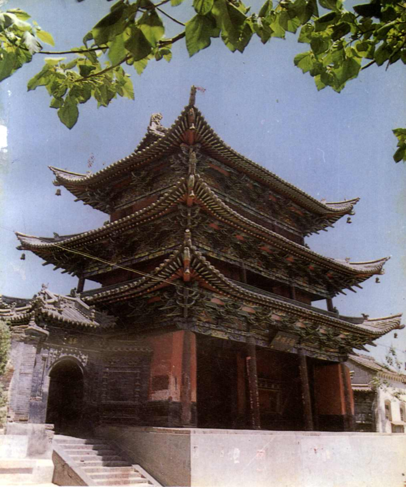
▲ 黎城县城隍庙门楼三节楼
