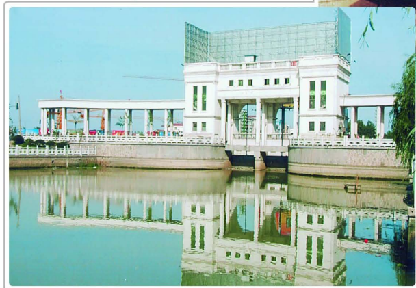
▲2002年改建后的涟东总干渠渠首闸——北门闸
