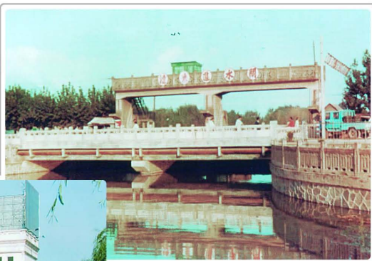
▲1958年建成的涟东总干渠北门闸
