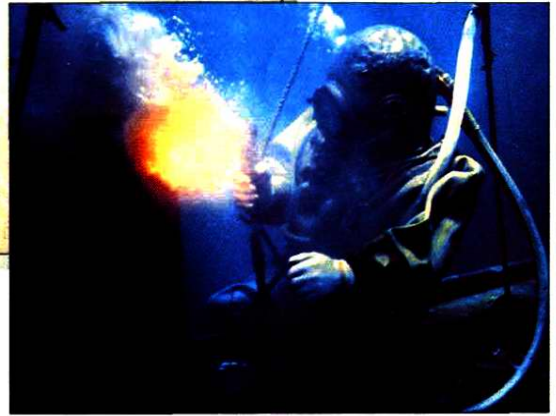
潜水员在水下进行切割
