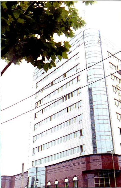
2008年底竣工的上海救捞局调度指挥综合大楼
