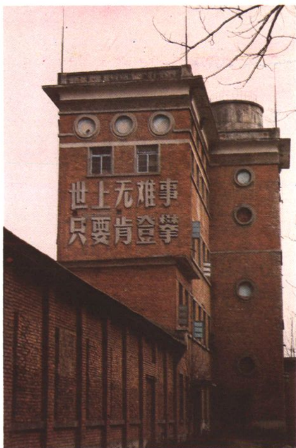
乡面粉厂生产楼
