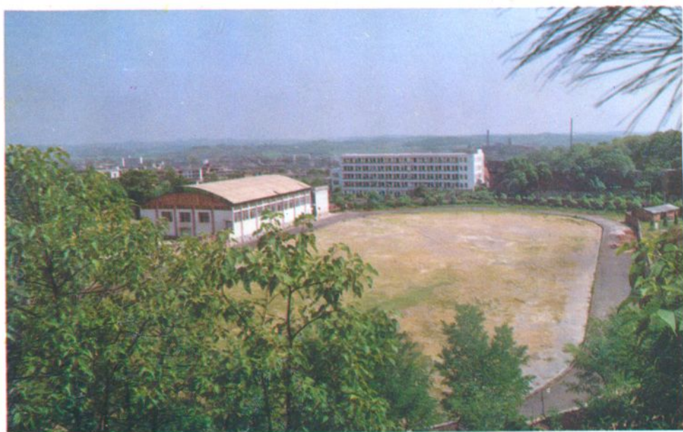
常宁县体育场于1987年建成使用，总投资为65万元。主要体育设施有：容纳2000名观众的体育馆一座， 180\text{ m}^2 的乒乓球训练室一间， 50\text{ m} \times 21\text{ m} 的标准游泳池和 17575\text{ m}^2 的田径运动场各一个。图为体育场一角。
