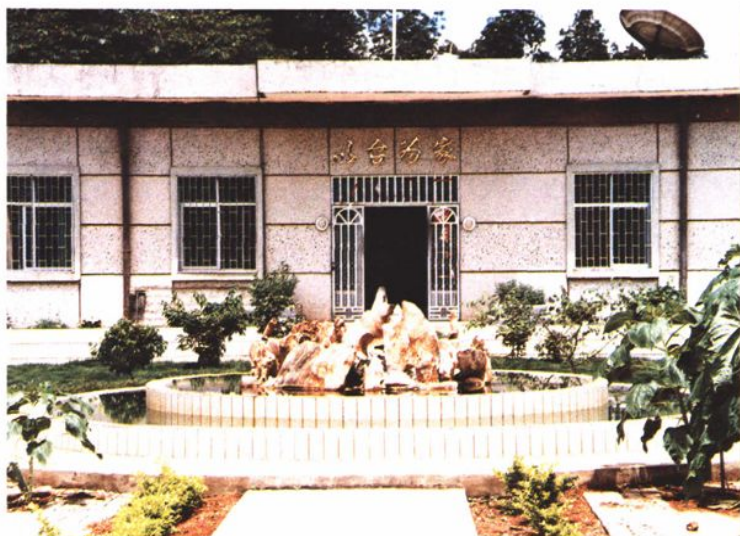
耿马中波台建于1986年。图为耿马中波台机房。
