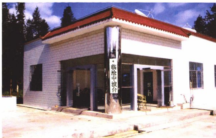
临沧中波台(699台)创建于1969年，曾几度搬迁重建。图为2005年新建的中波台机房。
