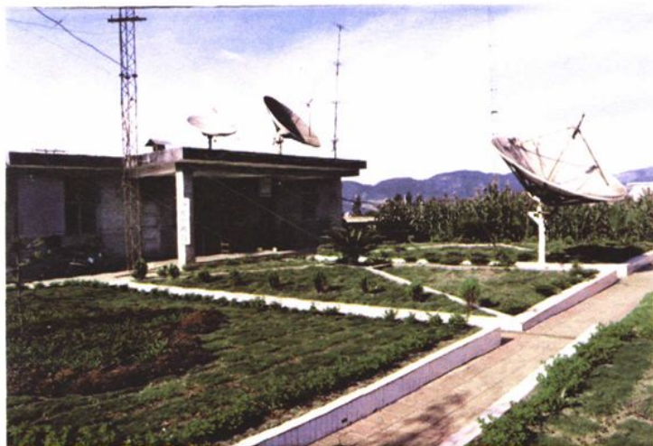
沧源中波台建于1991年。图为沧源中波台机房。
