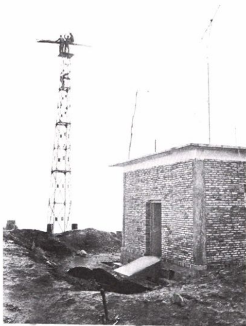
1979年建设中的叫雨山电视差转台。图为安装调试发射天线。
