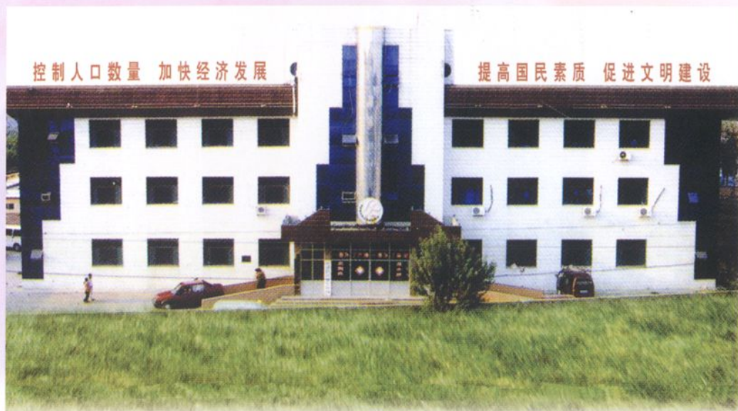
2000年落成的县计生委、县妇幼保健计生站办公大楼
