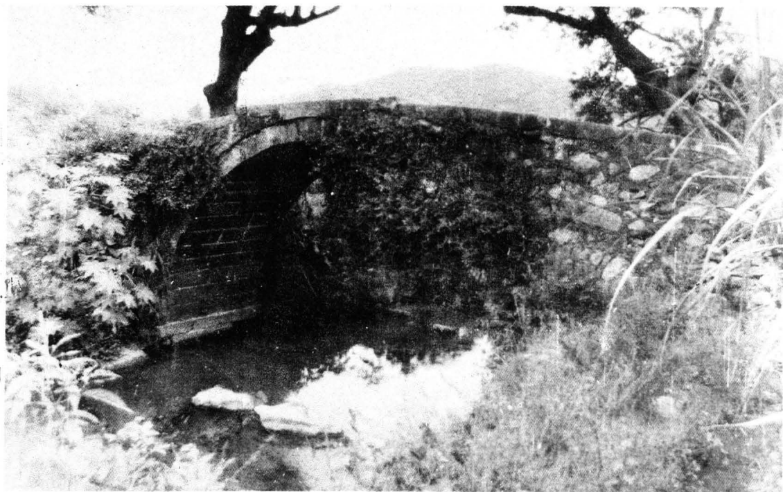
右水乌石下古石拱桥
