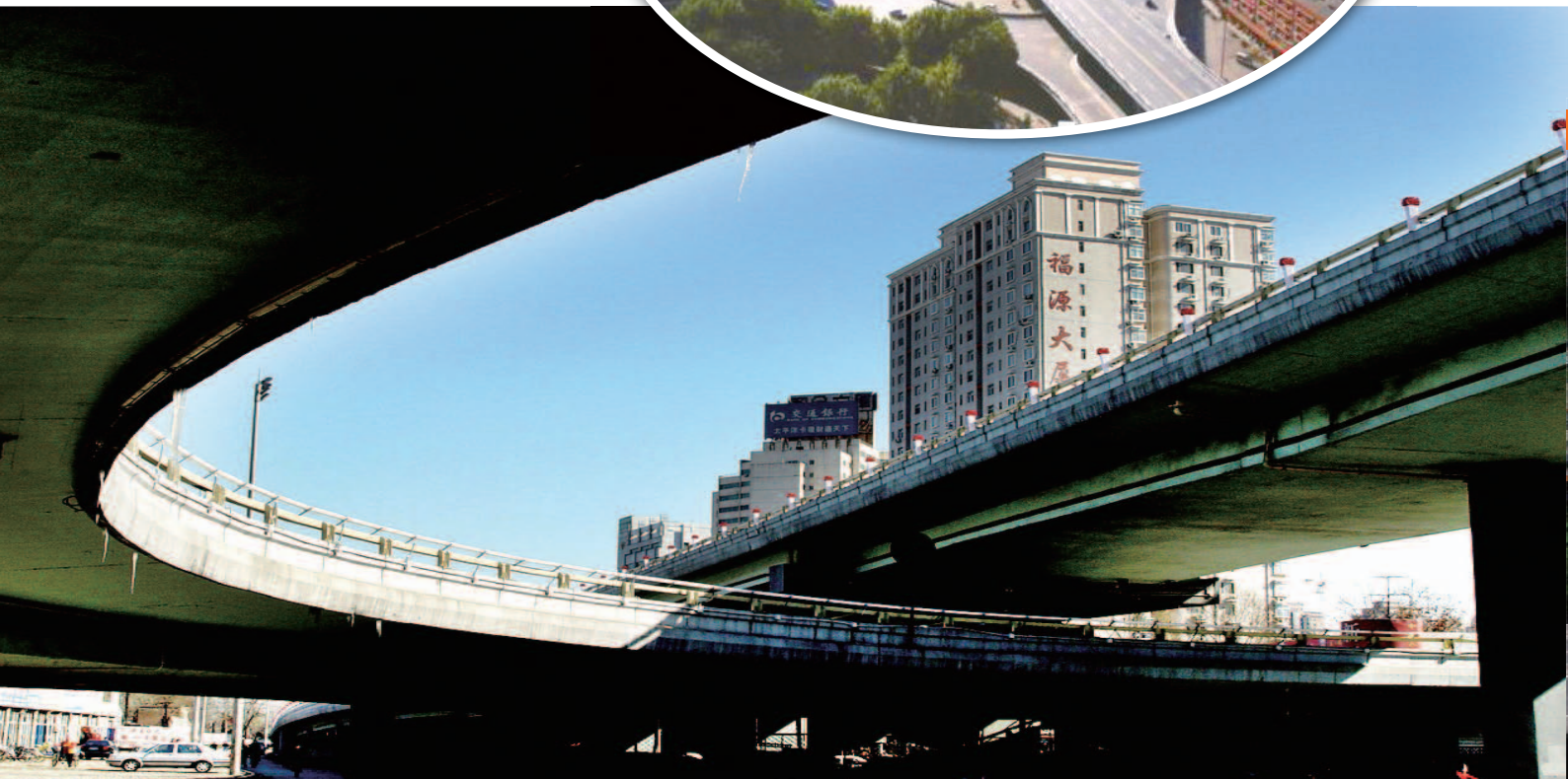
棉一立交桥（建和桥）
