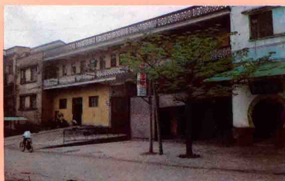
梅县地区粮油转运站
