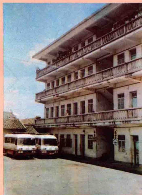
大埔县粮运公司办公楼
