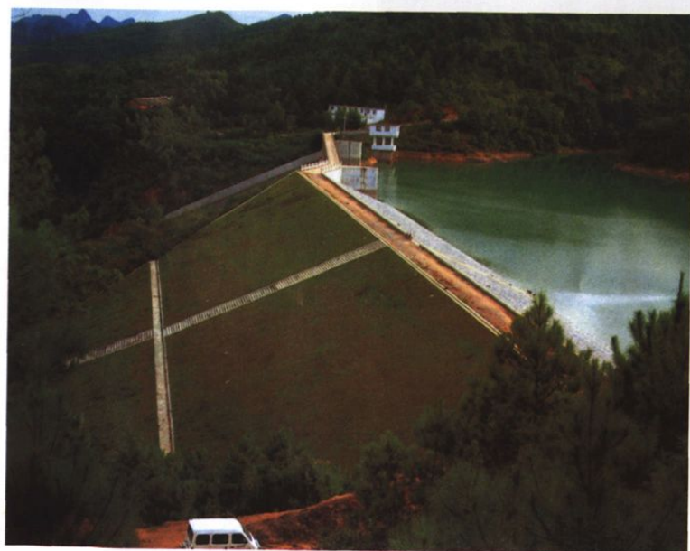
加固后的扶绥县新安水库大坝
