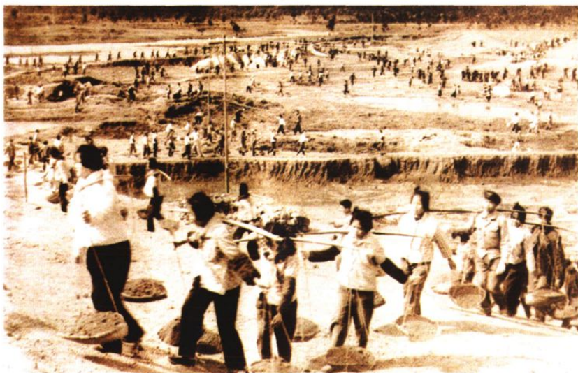
1972年横县快龙水 库施工现场
