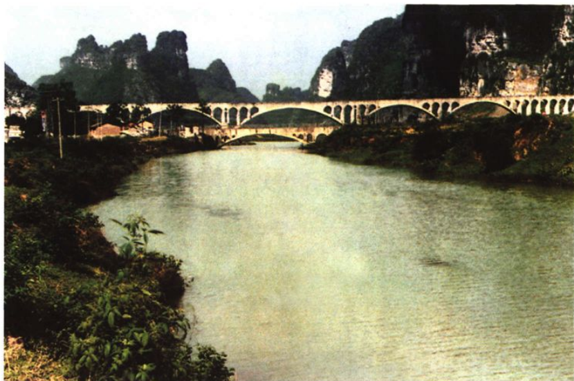
上林县三保支渠洋渡渡槽
