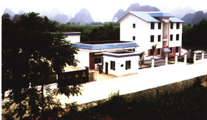
边境供水工程龙州县水口 供水厂
