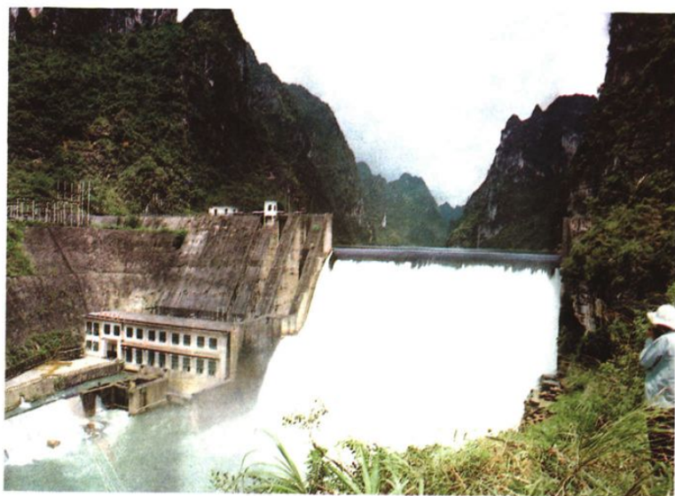
大新县那岸水电站
