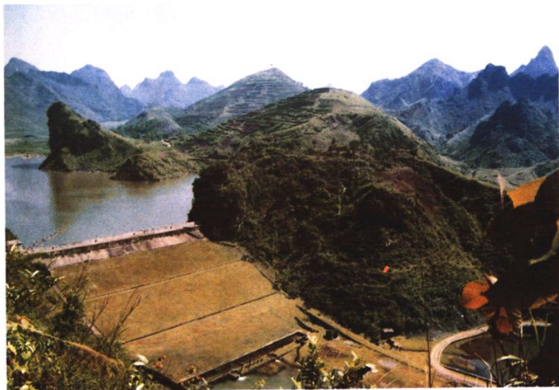
上林县东敢水库 大坝全景
