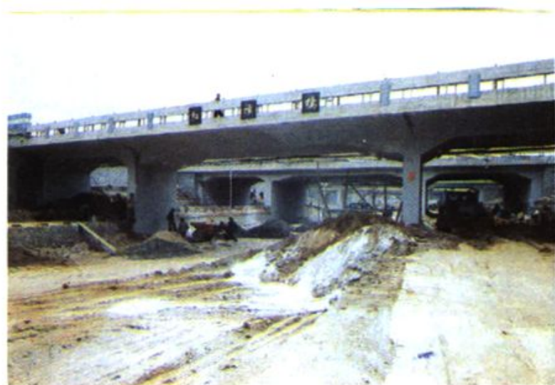
这是由我公司承建并获省金牌的工程：五座三孔式红旗立交桥。下图为施工中的红旗桥。
