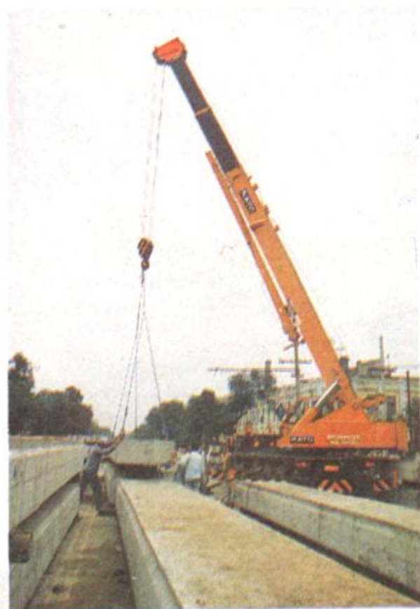
施工现场移运大梁。(1985年)
