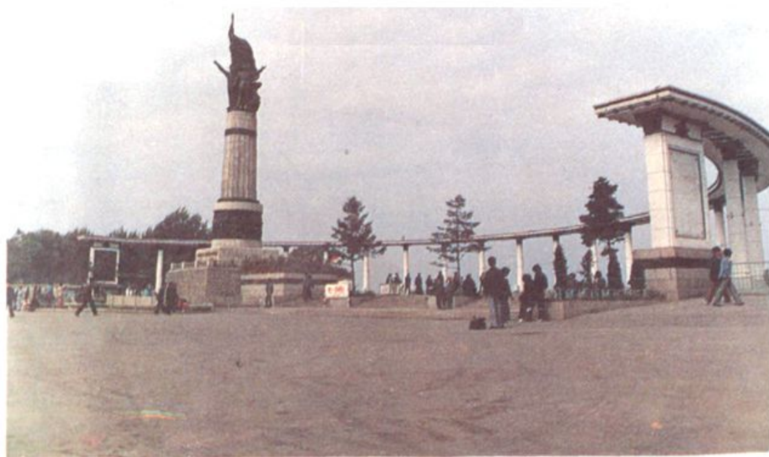
我公司承建的防洪纪念塔广场。
