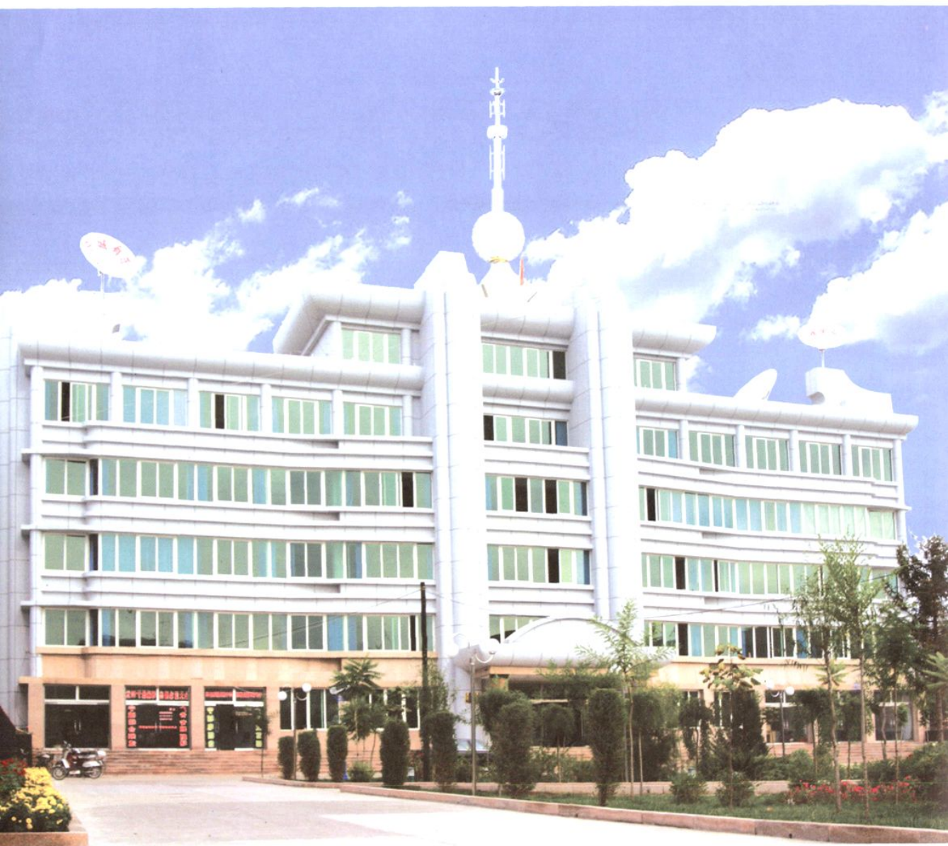
广电中心办公大楼
