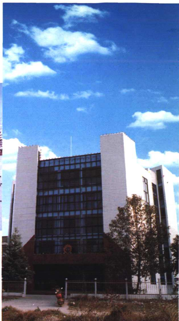
永嘉县土地管理局办公楼
