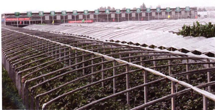
铺设农民致富“金桥”——五莲县有机高效生态农业示范园
