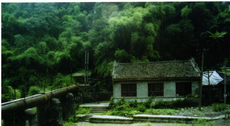
境域小水电站
