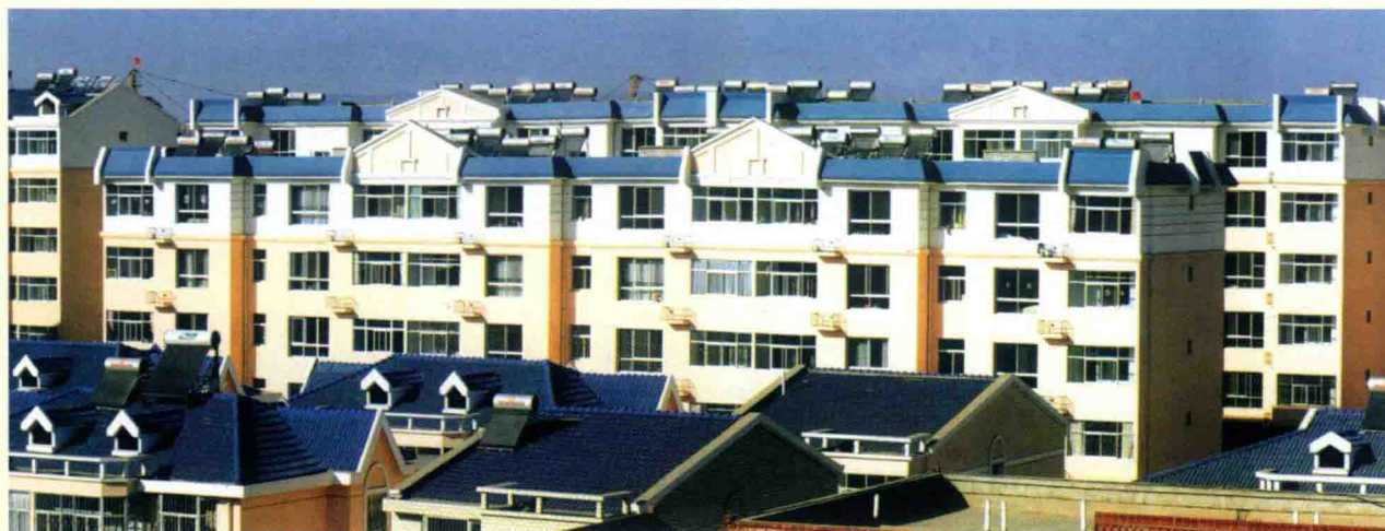
康泰居民住宅小区
