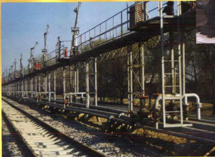
6、铁路专用线及油品接卸栈桥
