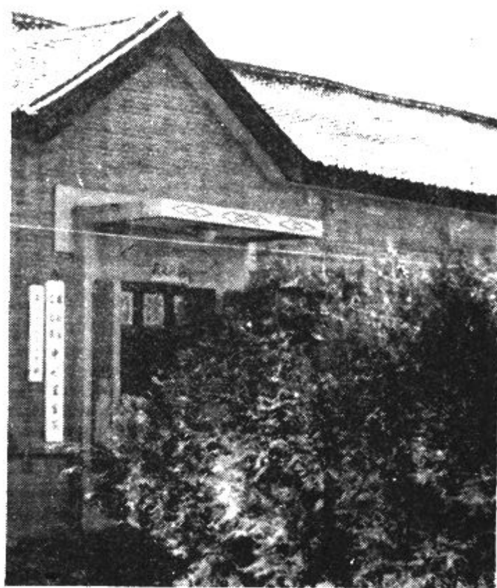
上瑶镇中心卫生院外景
