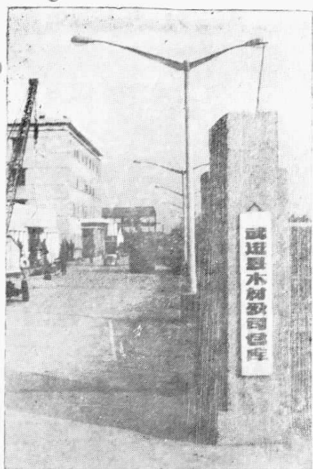
武进县木材公司三井仓库
