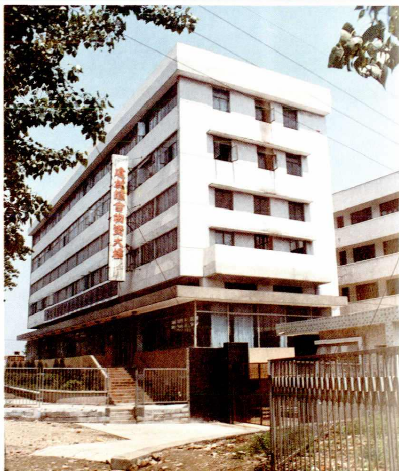
武进县建材工业公司综合物资大楼
