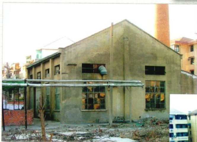
◎ 原医院锅炉房
