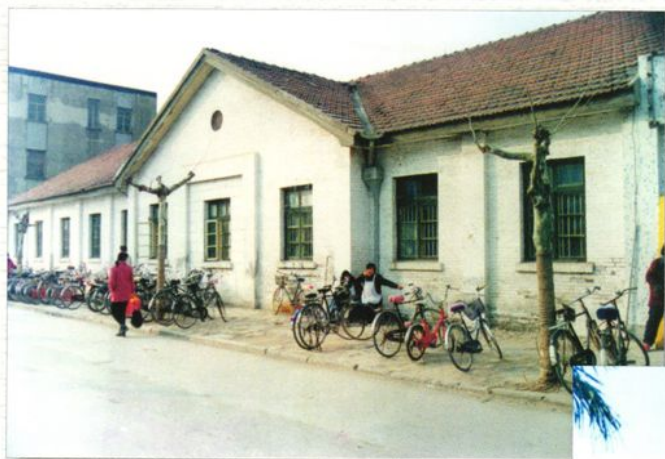
◎ 1960年建成的原门诊用房
