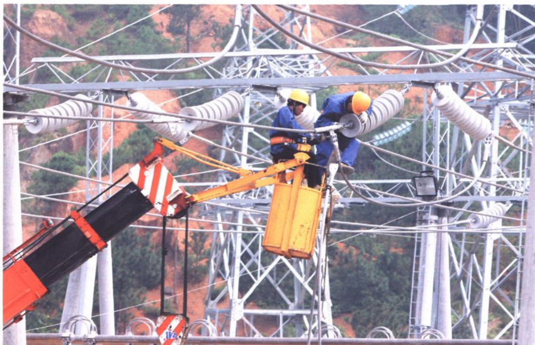
◆ 220千伏青田变电所施工现场
