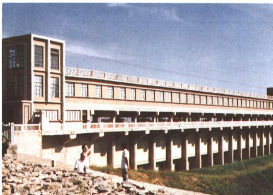
黄河林辛进湖闸，建于1967年，1979年改建，15孔，设计流量1500立方米/秒，1982年8月启闸分洪。王永熙 摄
