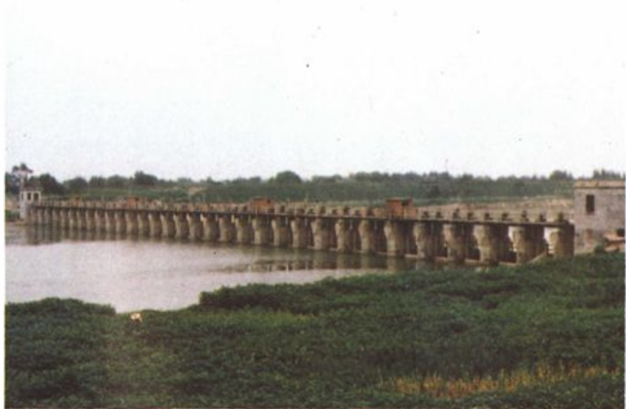
洙赵新河于楼节制闸1971年竣工，闸底长162米，31孔，流域面积4030平方公里。王永熙 摄
