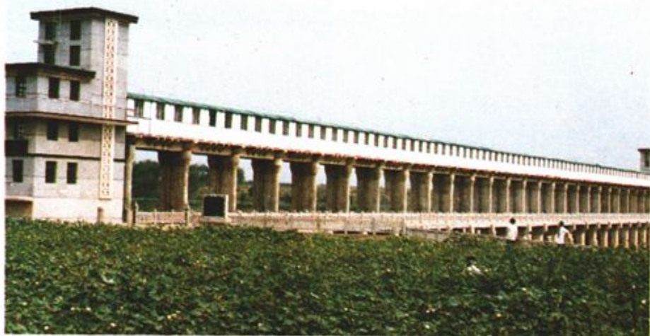
东渔河徐寨节制闸1986年5月竣工，全长178.5米，26孔。
