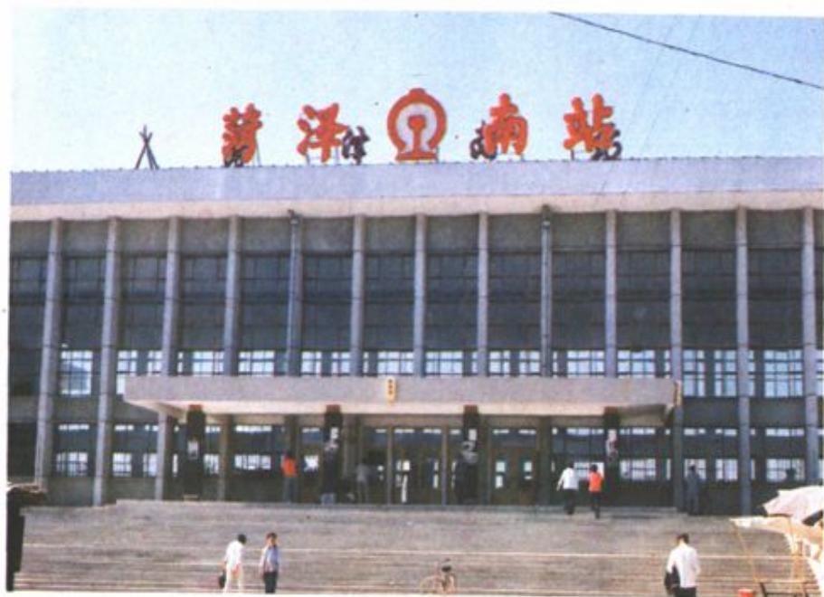
新菏铁路菏泽南站。
