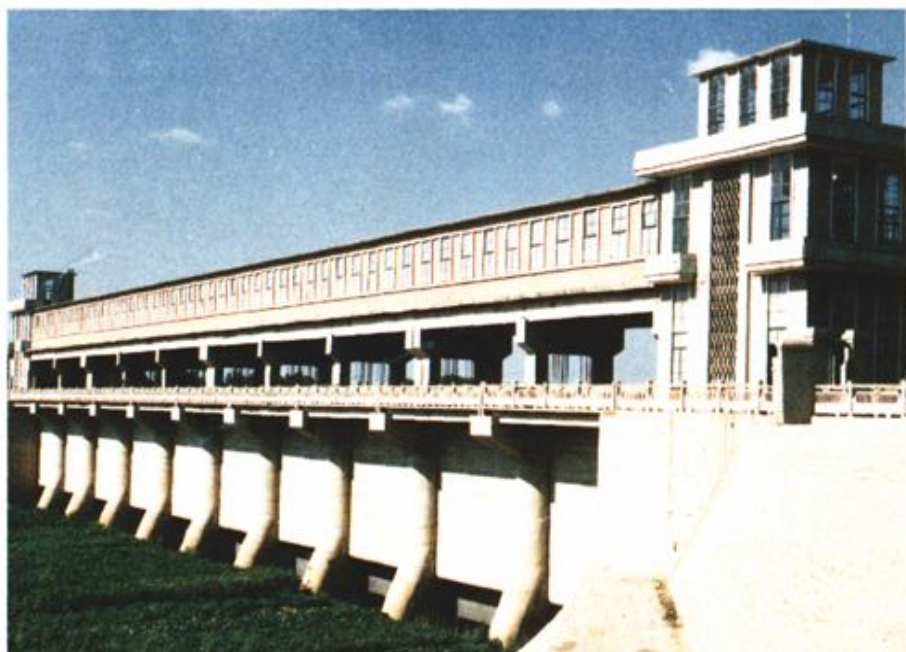
黄河十里堡进湖闸建于1960年，1981年改建，10孔，设计流量2000立米/秒，1960年和1982年8月启闸分洪。 王永熙 摄
