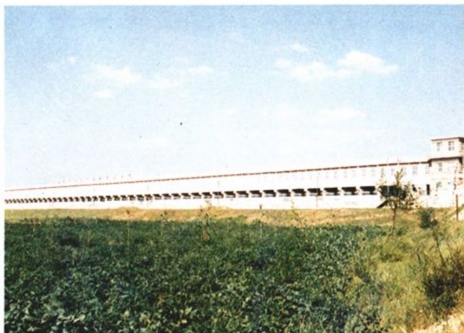
黄河石洼进湖闸建于1967年，1978年改建，49孔，设计流量5000立米/秒。
