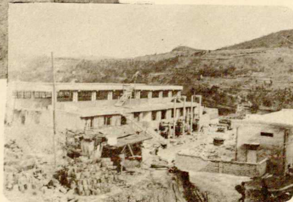
在建工程一天然气发电厂 (1988年5月摄)
