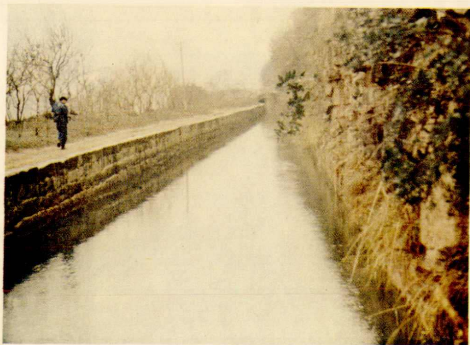
两河电站引水渠道 (1988年5月摄)
