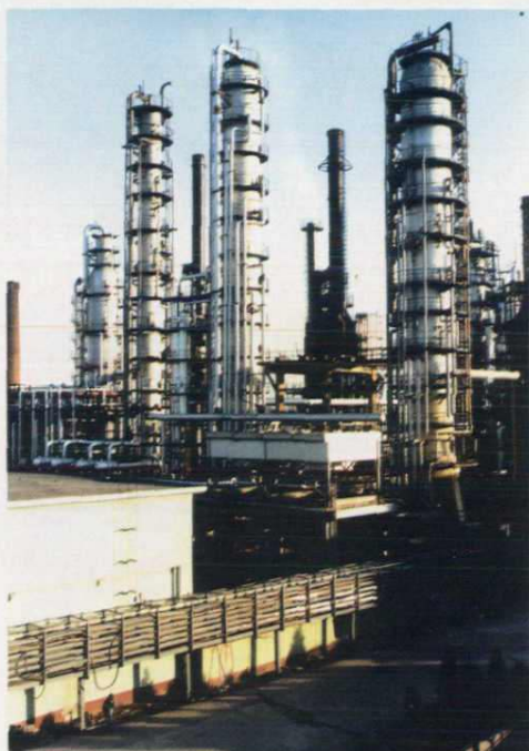
▲加工能力为 250 万吨/年（主要设备为 400 万吨/年）常减压装置
