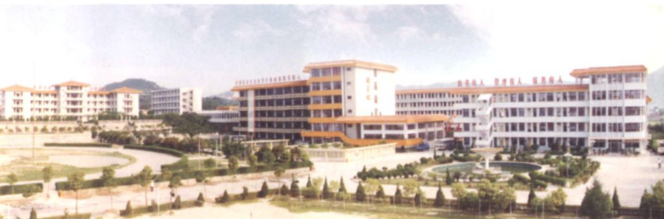
1988年，泉州电力学校校园
