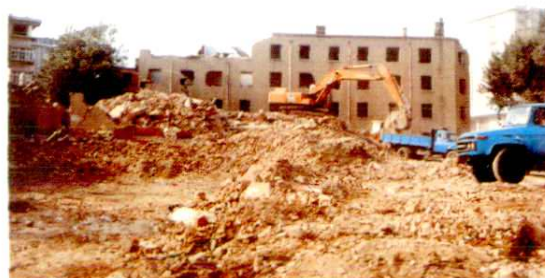
新开市场周边异地搬迁300余户，拆迁面积1.2万平方米，将建成旅顺最大的花园广场，图为拆迁工程正在进行中。
