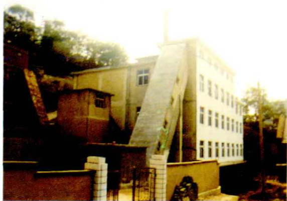
新建长江路锅炉房
