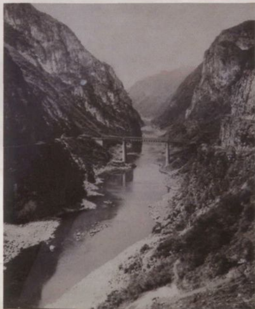
乌江渡水电站坝址原貌
