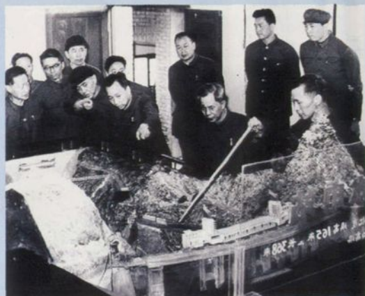
国务院原副总理方毅(前排右二) 到乌江渡水电站视察
