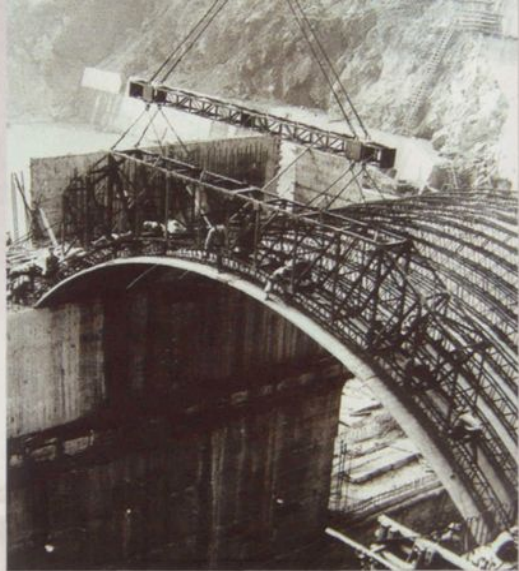
乌江渡水电站一号厂房施工
