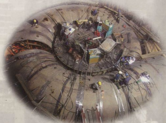
扩建工程#4机蜗壳组焊
