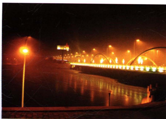
七里河大桥夜景
