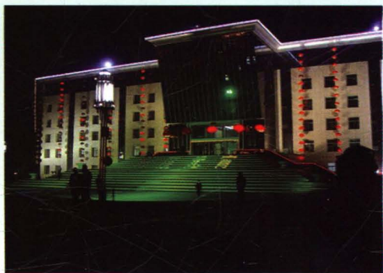
朔城区委、区政府办公楼
