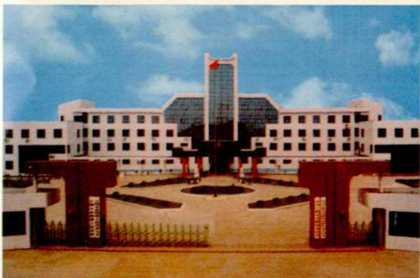
青阳镇政府大楼
