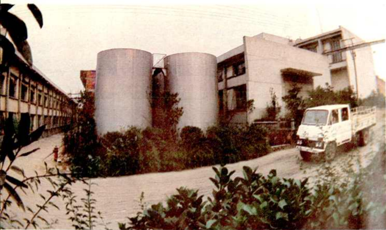
八十年代经过扩建后的新厂貌一角。
