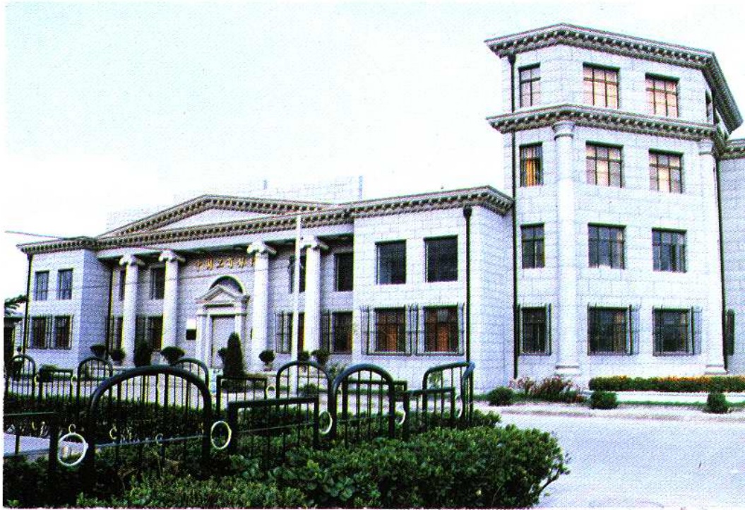
中国工商银行 天津市东丽支行营 业楼
