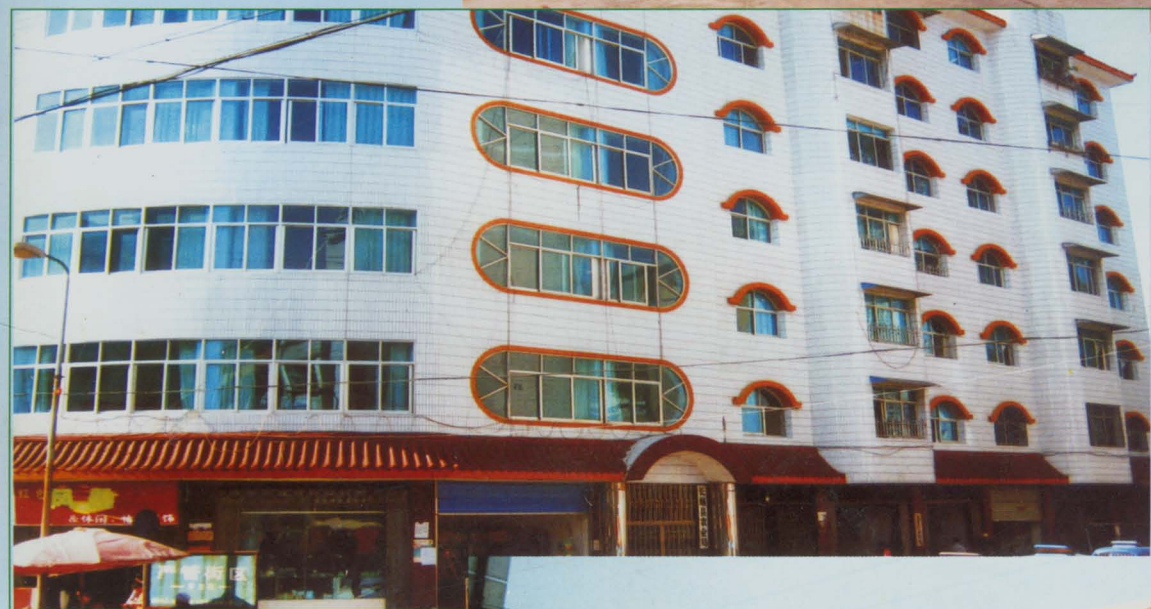
▲ 农业局办公大楼
