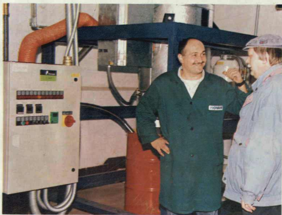
西德专家在新皂化工总厂 调试引进的 PC 薄膜生产设备
